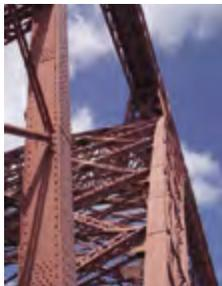
Il a fallu du béton armé et plus de 3 000 tonnes de poutrelles de fer fixées avec des centaines de milliers de rivets pour construire le viaduc. La peinture rouge permet de protéger le fer de la corrosion.
