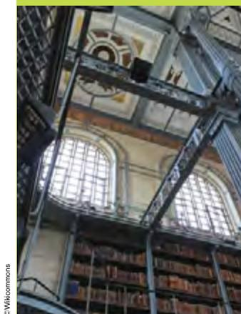
L'ossature métallique permet de résister aux tremblements de terre et aux cyclones, fréquents aux Antilles. On remarque que le métal autorise la finesse des formes : nombreuses cannelures des colonnes, volutes et feuilles forgées sur les chapiteaux ou les poutres.
